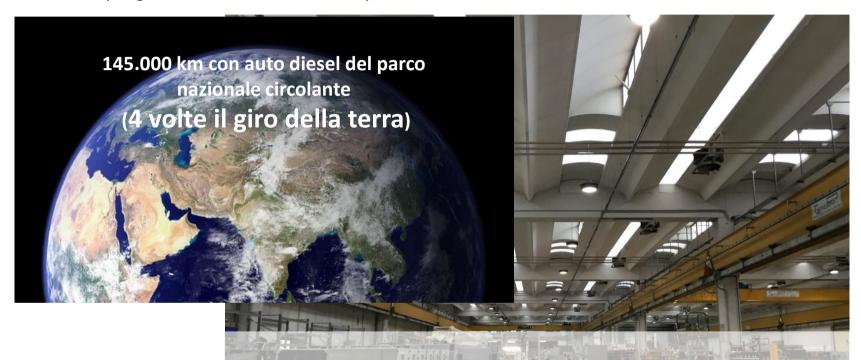
E' stato avviato un piano pluriennale di sostituzione dei corpi illuminanti nei reparti di lavorazione ed in quelli ad uso ufficio. Allo stato attuale è stata sostituita la quasi totalità di corpi illuminanti con apparecchi a LED che garantiscono una riduzione di emissioni di 25 tonCO<sub>2</sub>/anno.
